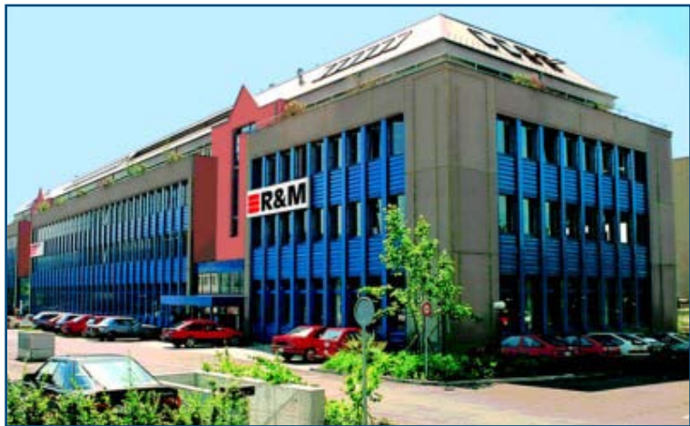
Schweizer Spezialist für Verkabelungs- und Systemlösungen: Reichle & De Massari hat in Wetzikon die Montage und die Logistik in zwei nebeneinander liegenden Gebäuden untergebracht.
